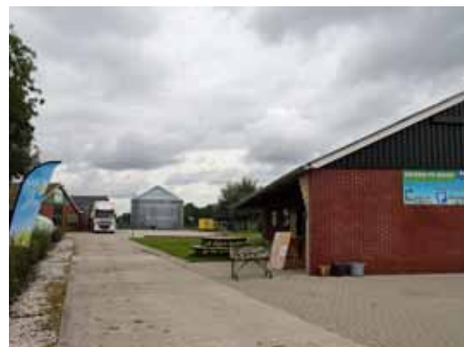
Links de twee pluimveestallen, rechts de loods met kantine en eierautomaat
